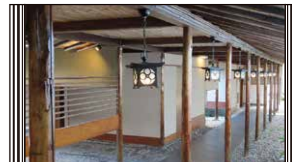
(翠水へ続く渡り廊下)
