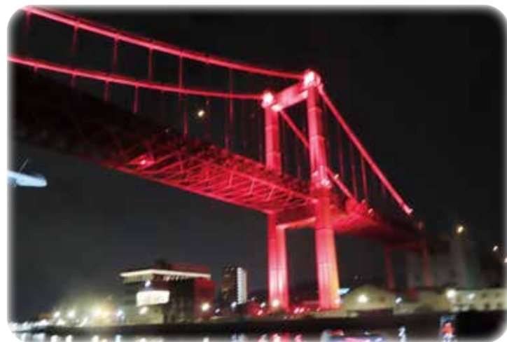
(全長627mの若戸大橋)
